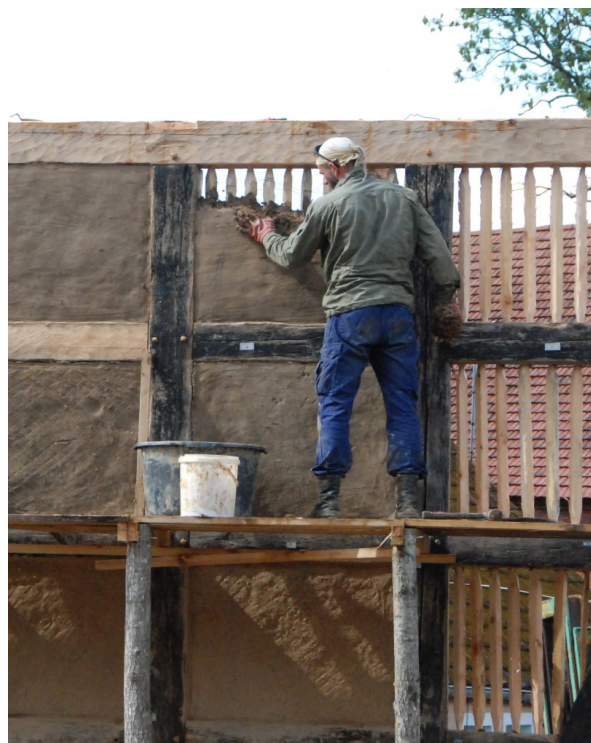
Wypełnianie gliną konstrukcji ryglowej; fot. Dawid Gonciarz
