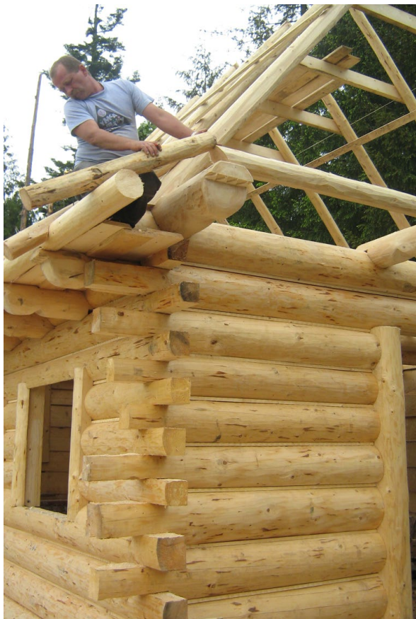
Łączenie ścian optykanych welnionką; fot. Inka Bogucka
