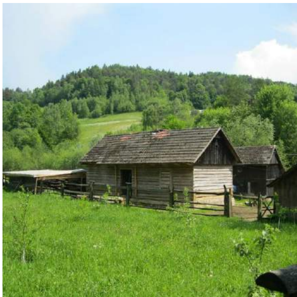
Zabudowania młyńskie w Roztoce-Brzezina – stan przed remontem, pocz. XXI w.
